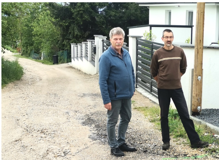
A kivitelező részéről Nagy Ferenc ügyvezető, az Önkormányzat részéről Szarka Róbert településüzemeltetési ügyintéző tekinti meg a munkaterületet
